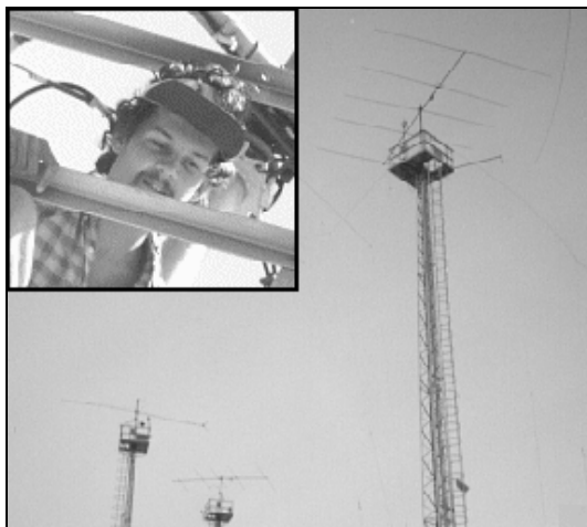
Képek a paksi rádióamatőrök telkéről: Kiss István a 30 méter magasan a megfigyelőkosárban (fotó: Bucsi Gábor), Rádiótelepi antennák (fotó: Kiss István)
